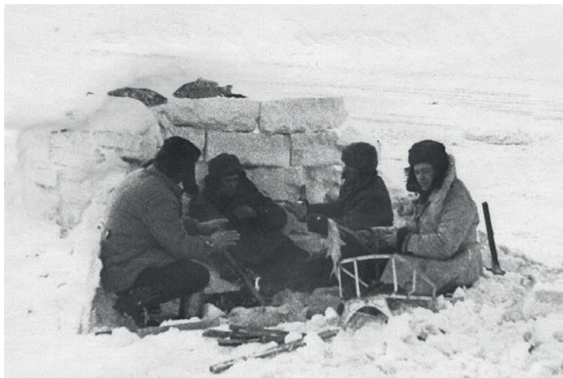
«Стенка» от ветра, сложена из «блоков», выпиленных ножовкой из снежного наста
