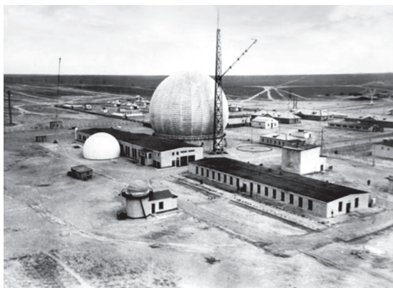
Рис.30. Комплекс сооружений одной из трех радиолокационных станций точного наведения
