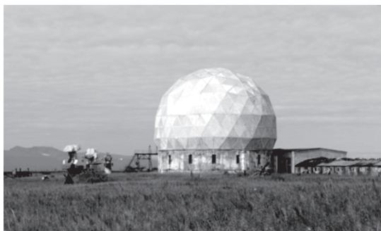
Рис.25. Радиолокатор РЭ-3, полный аналог радиолокатора РЭ-1, развернутый на Камчатке в измерительном пункте ИП-11 на полигоне Кура в поселке Ука. Предназначен для наблюдения за баллистическими ракетами, запускаемыми из полигона Плесецк, с акватории Баренцева моря и имеющими точку падения на полигоне Кура
