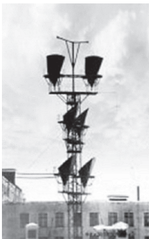
Рис.42. Антенная система с рупорно-параболическими антеннами у Главного командно-вычислительного центра
