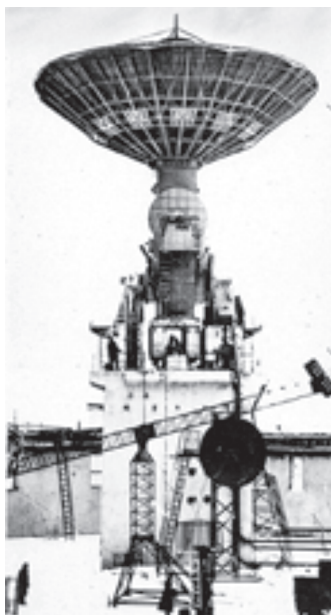
Рис.31. Главный антенный комплекс радиолокатора точного наведения в процессе монтажа
